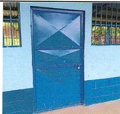
Foto 2: Sustitución de puertas
