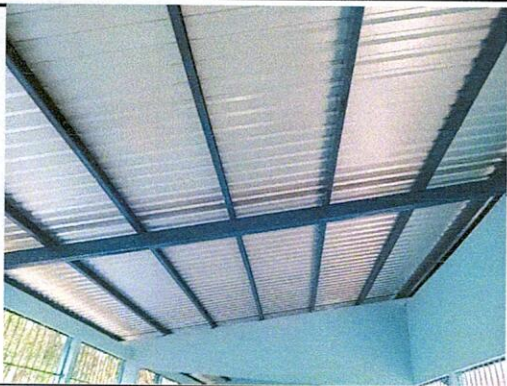
Foto1: Sustitución de entechado de aulas
